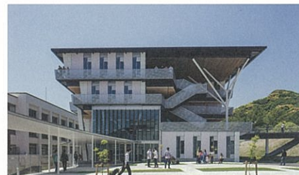
静岡理科大学建築学科棟 えんつりー 設計:古谷誠章+NASCA 施工:鈴与建設 撮影:浅川敏 コミッションング:脇坂圭一、丸田誠
